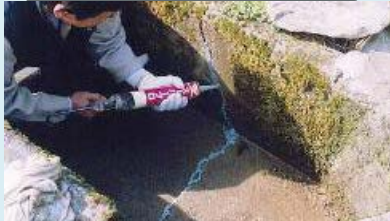
水路のひび割れ補修
