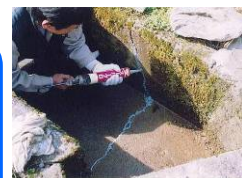
水路のひび割れ補修
