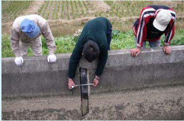
施設の機能診断
