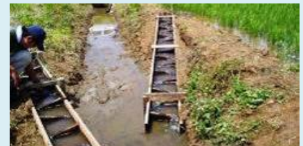
水田魚道の設置
