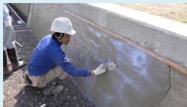
老朽化した水路壁のコーティング
