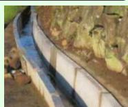
コンクリート水路の更新
