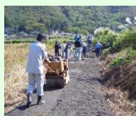
未舗装農道の舗装
