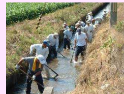
水路の泥上げ
