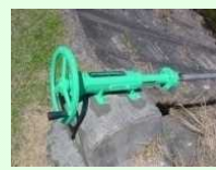
ゲート・バルブの更新
