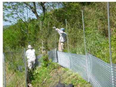
獣害防護柵の設置
