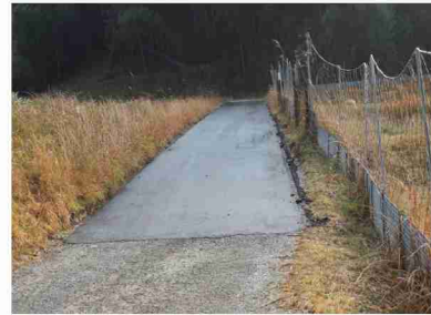
農道の更新(舗装)
