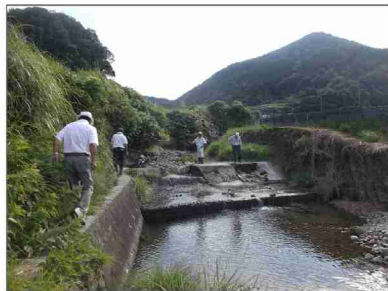
施設の機能診断
