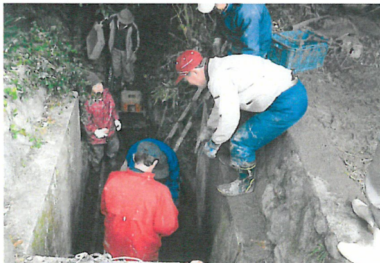
ウインチ操作による泥上げ
