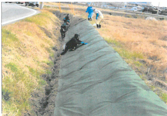
抑草シートの設置
