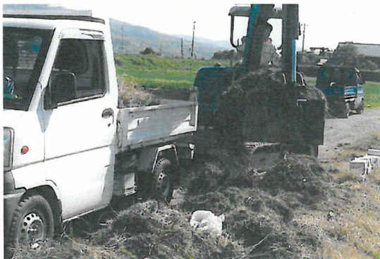
水路より除去した藻等の収集
