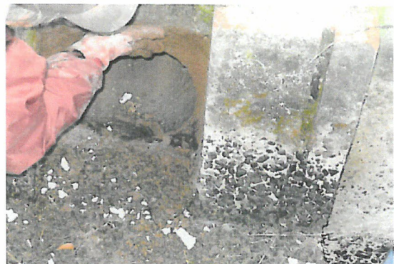
破損施設の改修
