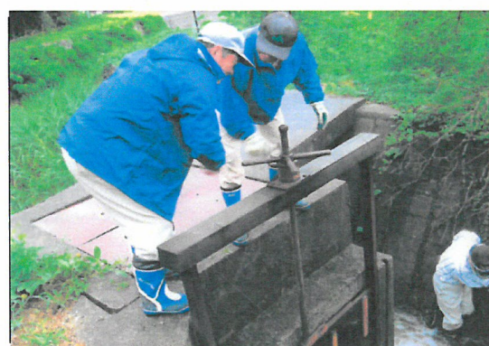
ゲートの保守管理
