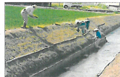
連歌川への魚類生息場所の設置と カバープランツ(ティフ・ブレア)の植栽
