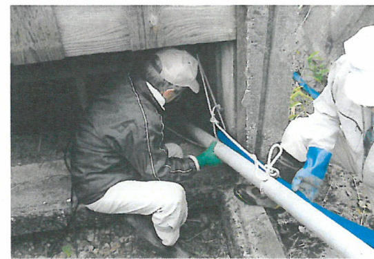
サイホン水路の水抜き作業
