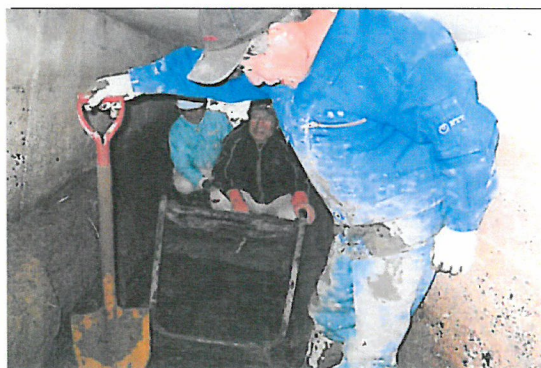
随道内の汚泥の撤去作業
