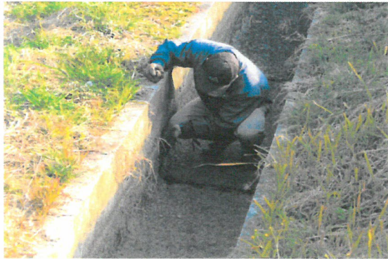
目地詰め(開水路)
