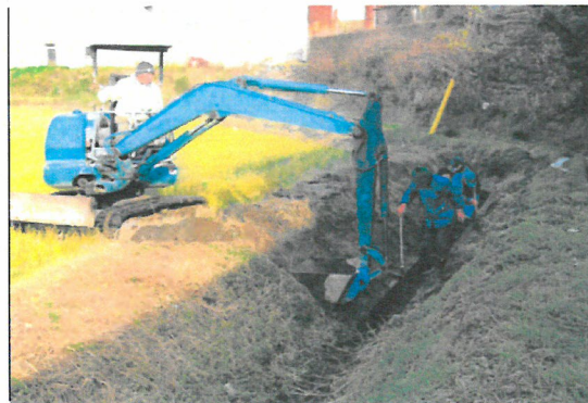
水路の泥上げ
