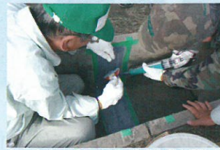
ホームセンターで入手できる材料で水路の目地を簡易補修
