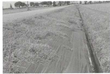
水路の法面に設置した防草シート。資材は見附市広域協定全体で共同購入するのでロットが大きく、安く仕入れられる。これも広域協定のメリット
