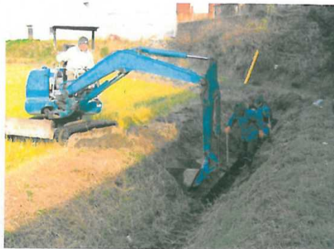
水路の泥上げ
