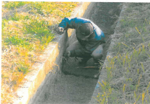
目地詰め(開水路)
