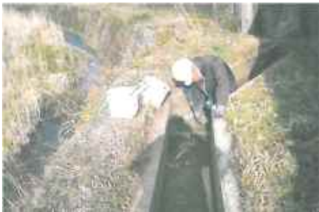
水路の補修 (目地詰め)
