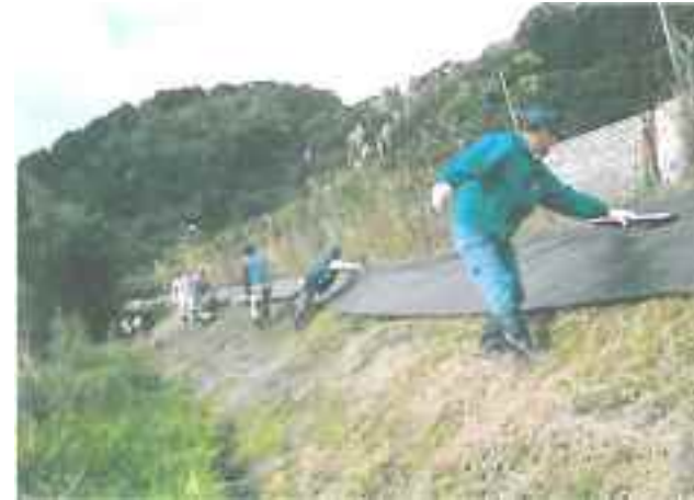
防草シートの設置
