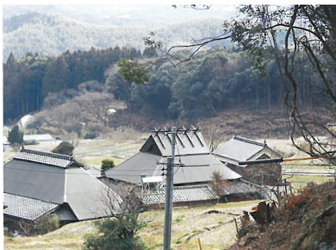
集落の周囲に緩衝帯を整備(周南市)
