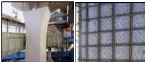
橋脚部に鉄筋を追加し部材厚を増す
