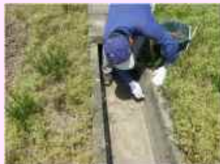
水路の目地補修についても、6活動 組織合同で技術研修会を実施
