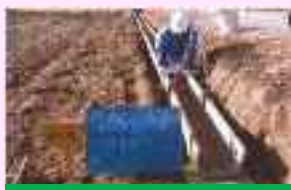
水路の補修・更新
