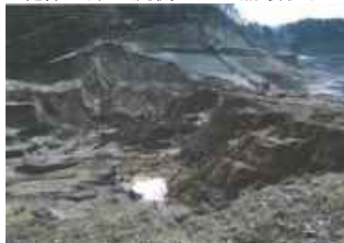
堤体左岸下流側からの崩壊状況
