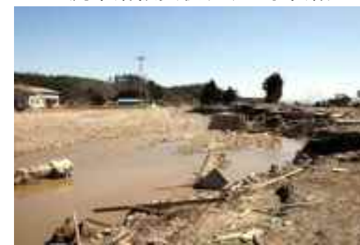
下流集落被災状況（北町集落）
