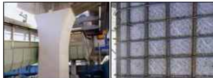
橋脚部に鉄筋を追加し部材厚を増す
