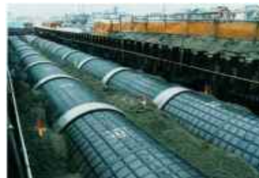
パイプライン側上部に特殊なネットを敷き、砕石で埋戻す
