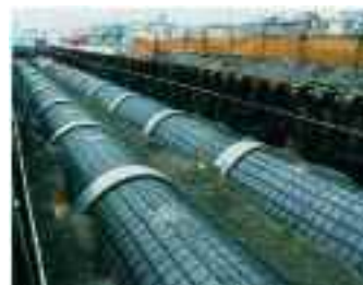
パイプライン側上部に特殊なネットを敷き、砕石で埋戻す
